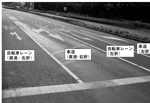
写真⑥ 左から直進・右折自転車、直進・右折自動車、左折自転車、左折自動車の4つのレーンに分岐
