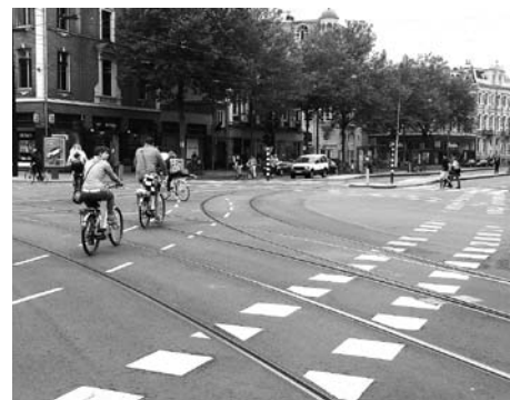
写真⑦ 交差点内にも直進、左折の自転車の通行帯が明確になっている
